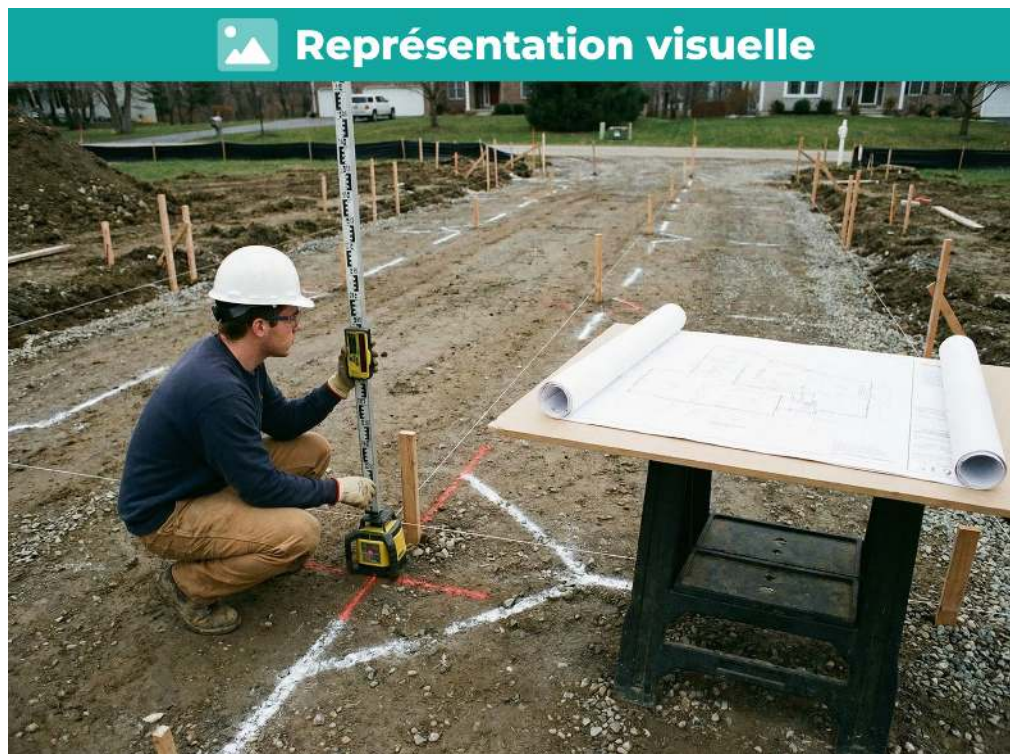
Vérification de pente: viser entre 1% et 2% pour un drainage optimal
